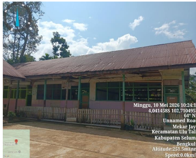
Gambar 2. Ruang Kelas yang Direhabilitasi
