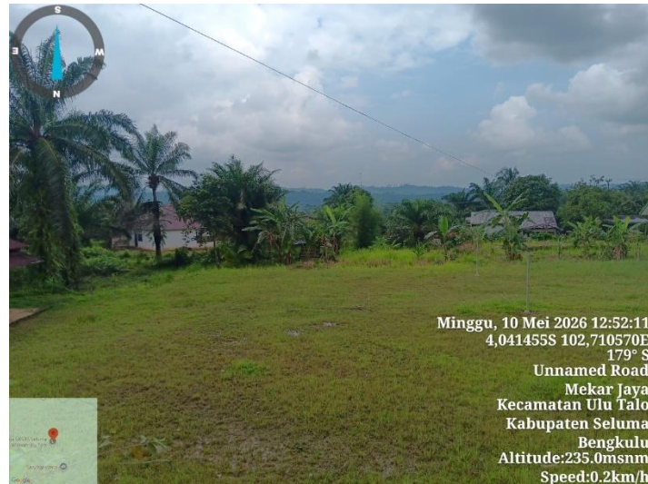
Gambar 6. Pembangunan Lapangan Upacara
