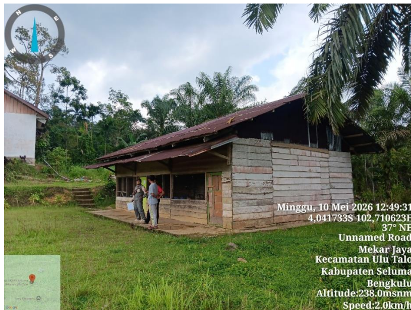
Gambar 4. Pembangunan Satu Unit Ruang Administrasi (ADM) Baru
