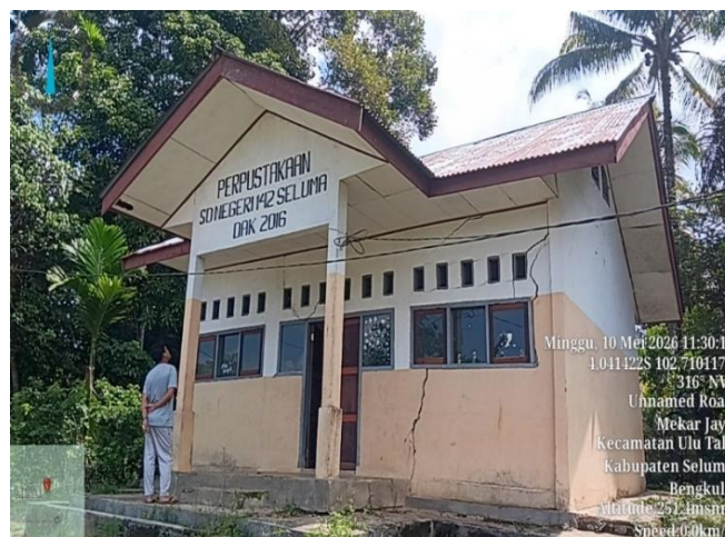
Gambar 3. Ruang Perpustakaan yang Direhabilitasi
