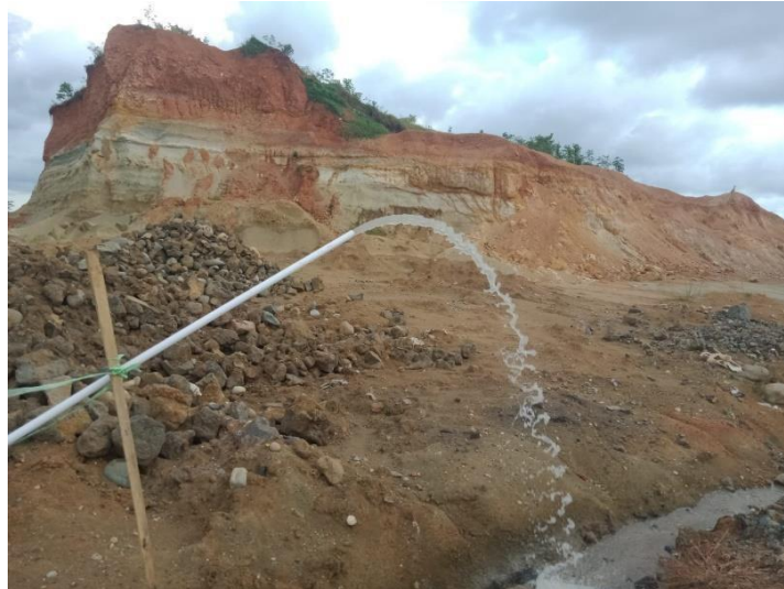
Gambar 2. Kondisi Aliran Air dari Sistem Sumur Bor di Perumahan Subsidi Kemiling Permai 5
