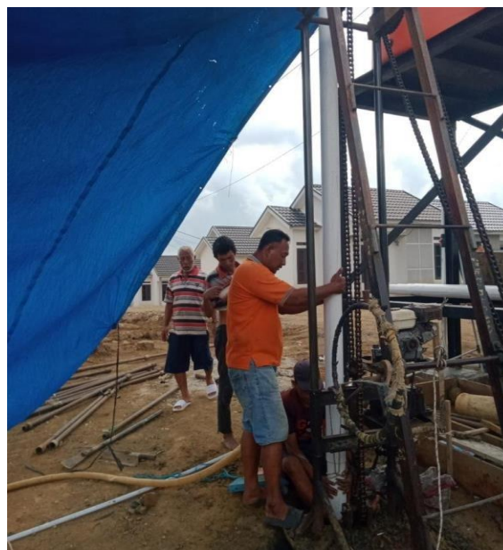
Gambar 1. Kondisi Sumur Bor di Perumahan Subsidi Kemiling Permai 5
